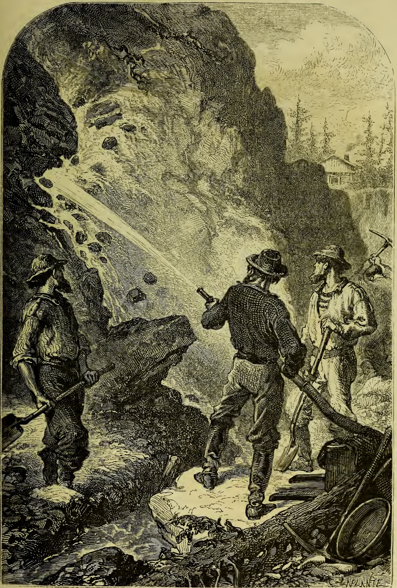
Fig. 147. — Méthode hydraulique inventée en Californie pour démolir les alluvions aurifères.
